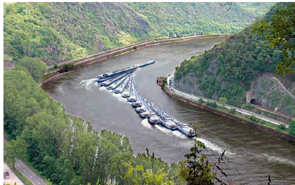
Schwankungen im Wasserdargebot und in den Abflüssen beeinflussen die Schiffbarkeit an schwierig zu befahrenden Strecken (Foto: BAW)
